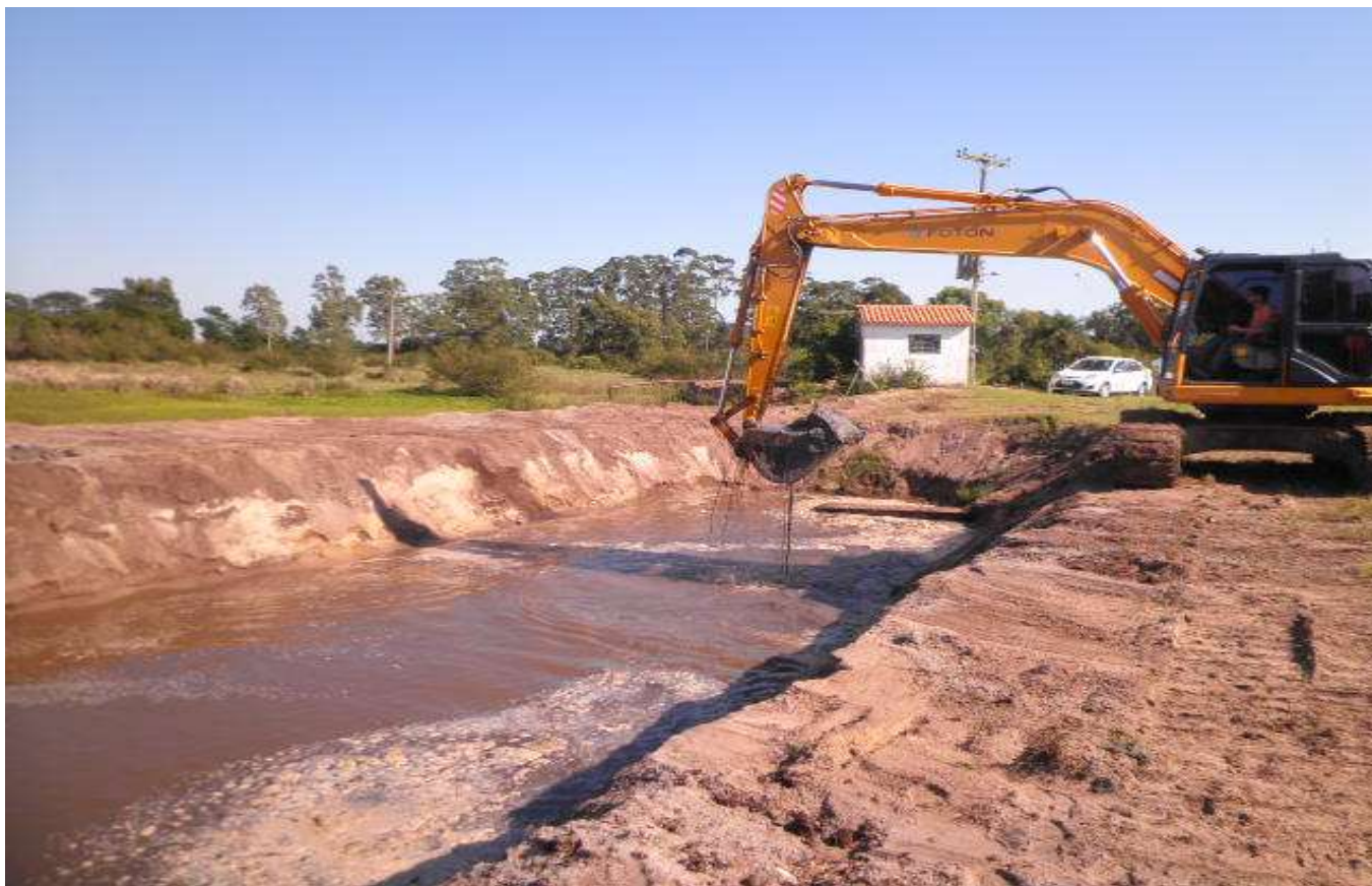
Figura 6 - Visão geral do trabalho da escavadeira hidráulica no canal de coleta de água bruta - Janeiro 2013.
