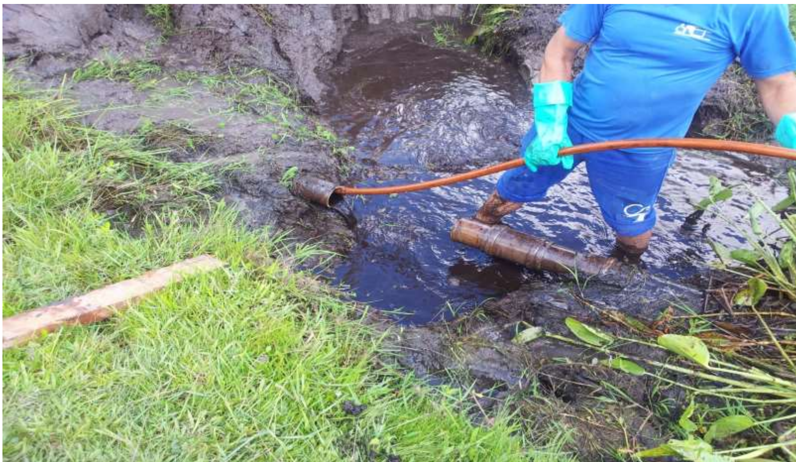
Figura 4 – Operação de limpeza da canalização que leva a água bruta até a ETA - Janeiro/2013.
