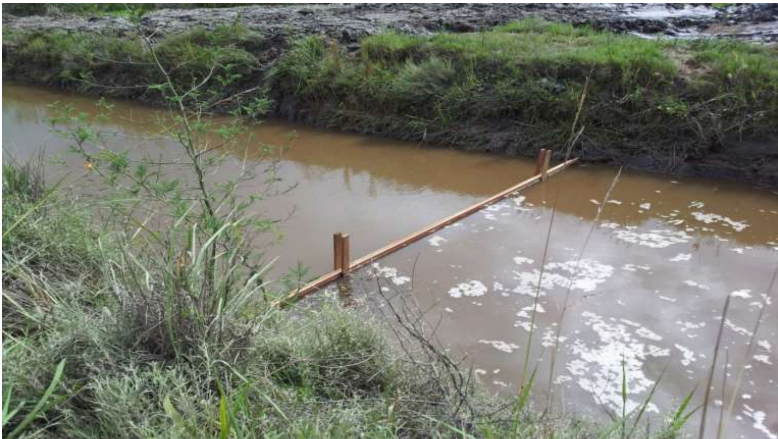
Figura 7 – Canal de captação de água bruta da ETA após a limpeza, detalhe de uma das barreiras físicas colocadas no canal para evitar a entrada de material flutuante junto à zona efetiva de captação de água.
